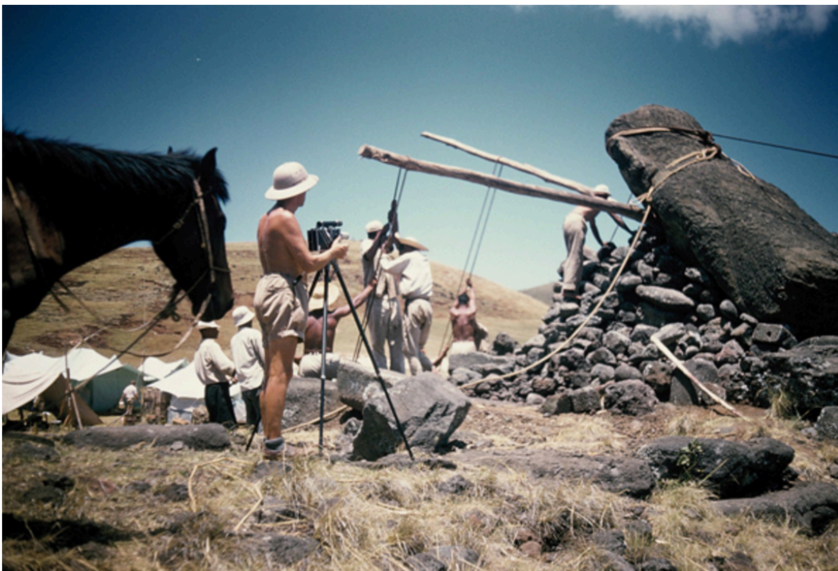
Figura 5.18: Levantando el moai del Ahu Ature Huki en Anakena. Expedición Noruega.1955-1956. (Registro K1321).
