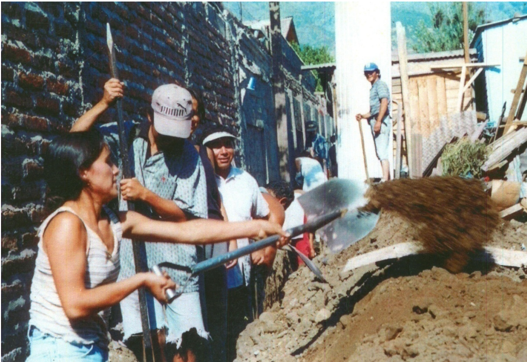
Proceso de construcción de alcantarillado, realizado por pobladores y pobladoras, a la par que se negociaba con las instituciones sanitarias pertinentes.
