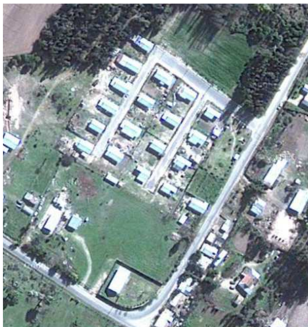
Figura N° 8 Villa “Charquicán” se ve en construcción
