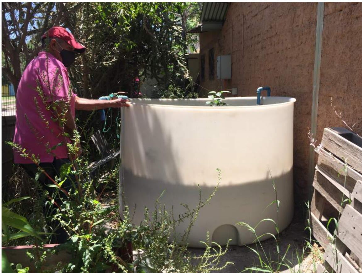
Fotografía 19: sistema de captación de aguas junto con Sr. Luis.
