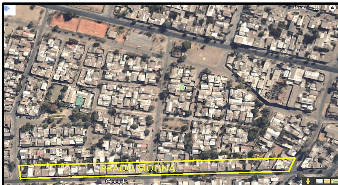
Fotografía aérea N°1 Prado Molina dentro de Polígono de intervención República de Venezuela
