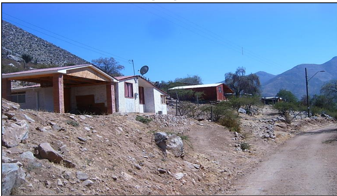
Imagen N°7. Espacios destinados a la instalación de viviendas de los comuneros agrícolas: 80mts 2 aprox. por comunero
