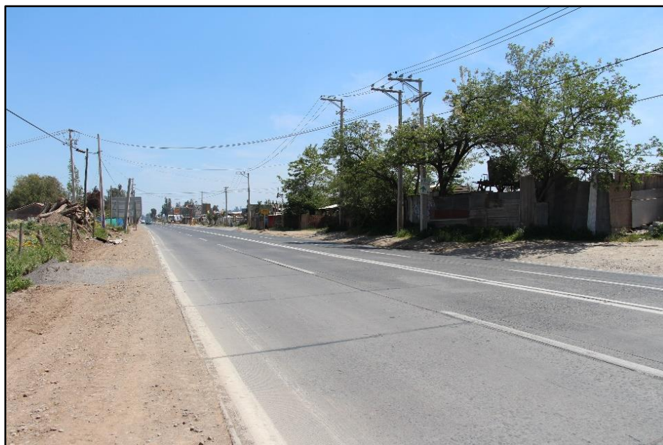
Imagen N°21. Calle Camino a San José de Maipo, Las Vizcachas
