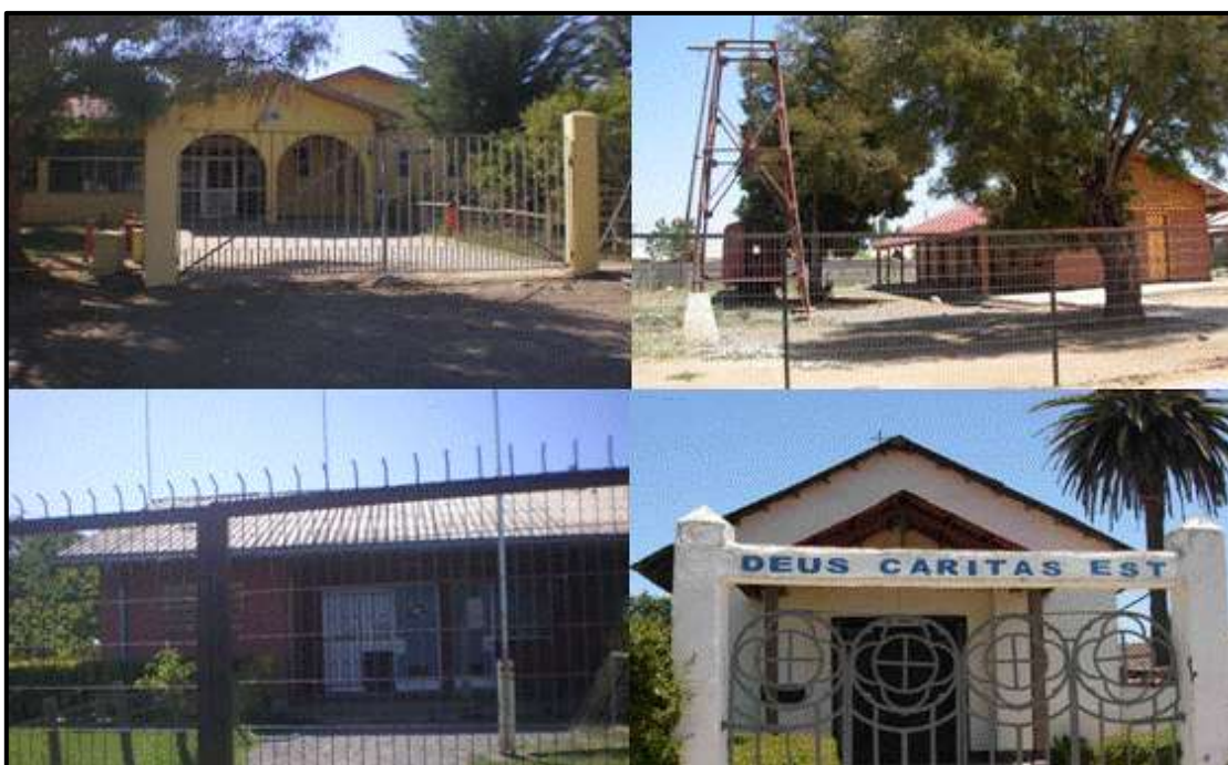
Figura 3: Localidad de Mercedes: Escuela, estación, posta e iglesia.
