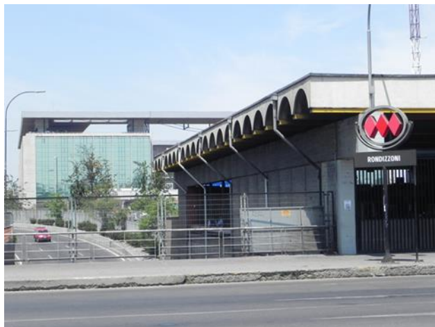
Figura 16. Vista actual del metro Rondizzoni. Fuente: archivo personal 2014.
