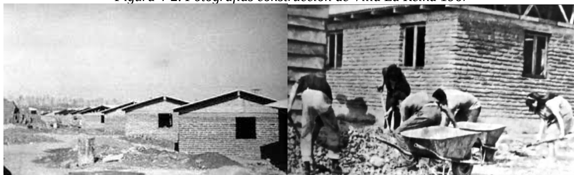
Figura 4-2. Fotografías construcción de Villa La Reina 1967
