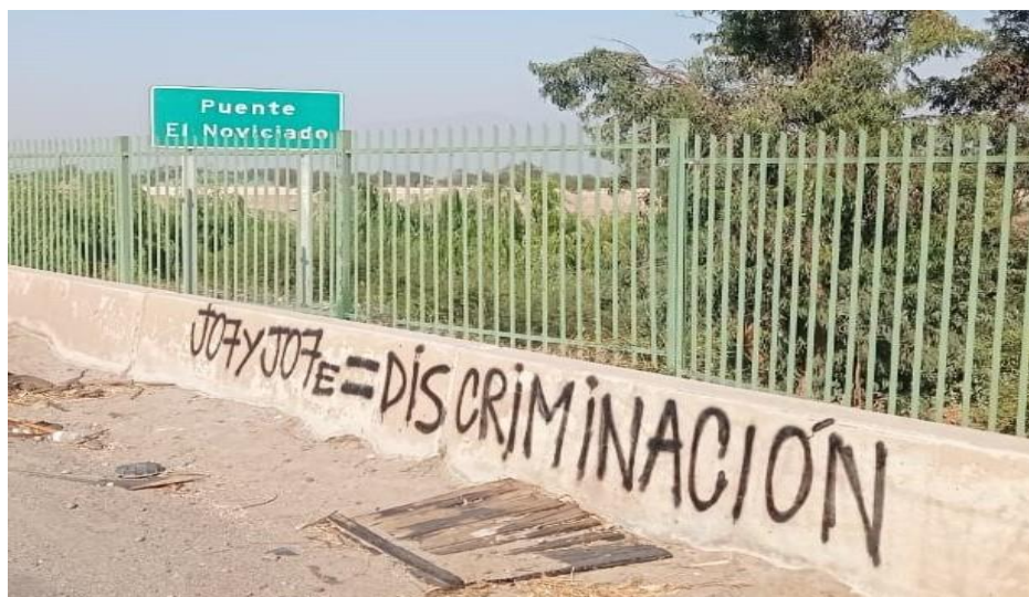
Abril 2021. Puente El Noviciado. Sector de El Noviciado. Pudahuel Rural. Fuente: Fotografía propia.
