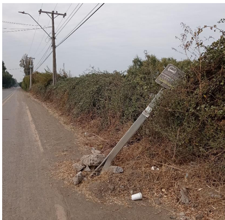
Abril 2021. Paradero Noviciado J07e. Sector El Noviciado. Pudahuel Rural. Fuente: Fotografía propia.
