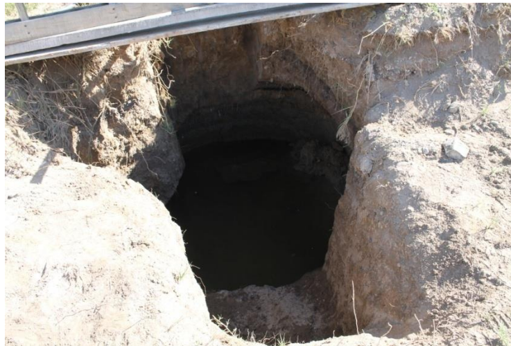
Imagen N°29: Pozo de extracción de agua en un goce singular.
