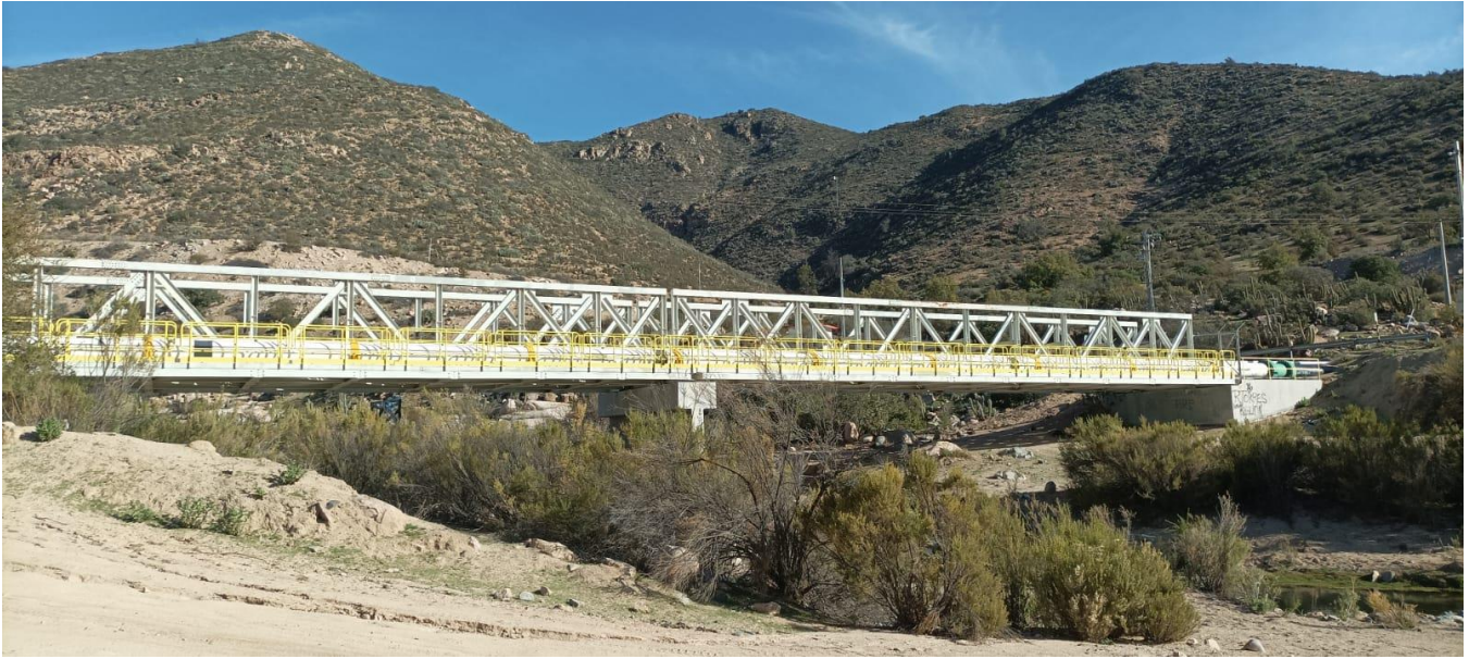
Fotografía tomada por Leandro Pardo. Concentraducto que travieza el valle camisas en la zona del embalse Corrales.
