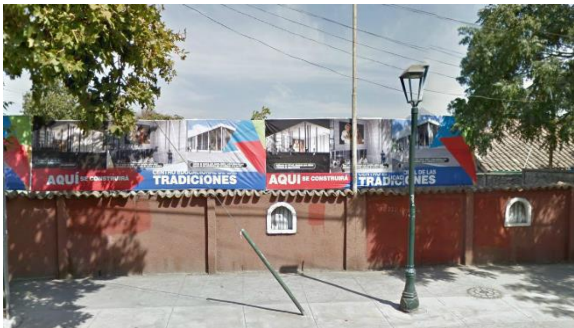
Imagen 2: Construcción Centro Cultural de Las Tradiciones
