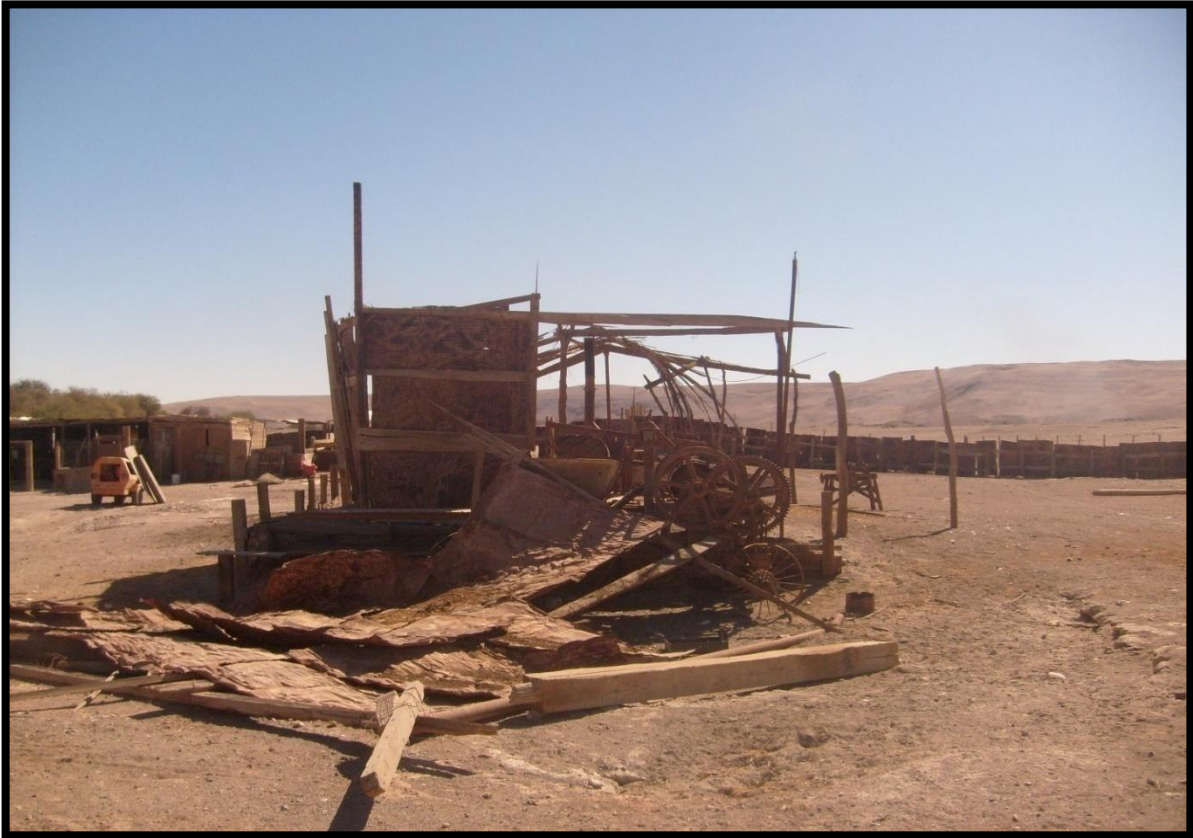
Fotografía n°14°: Cooperativa Campesina de Quillagua en su estado actual (2). Fuente: Propia (2013).
