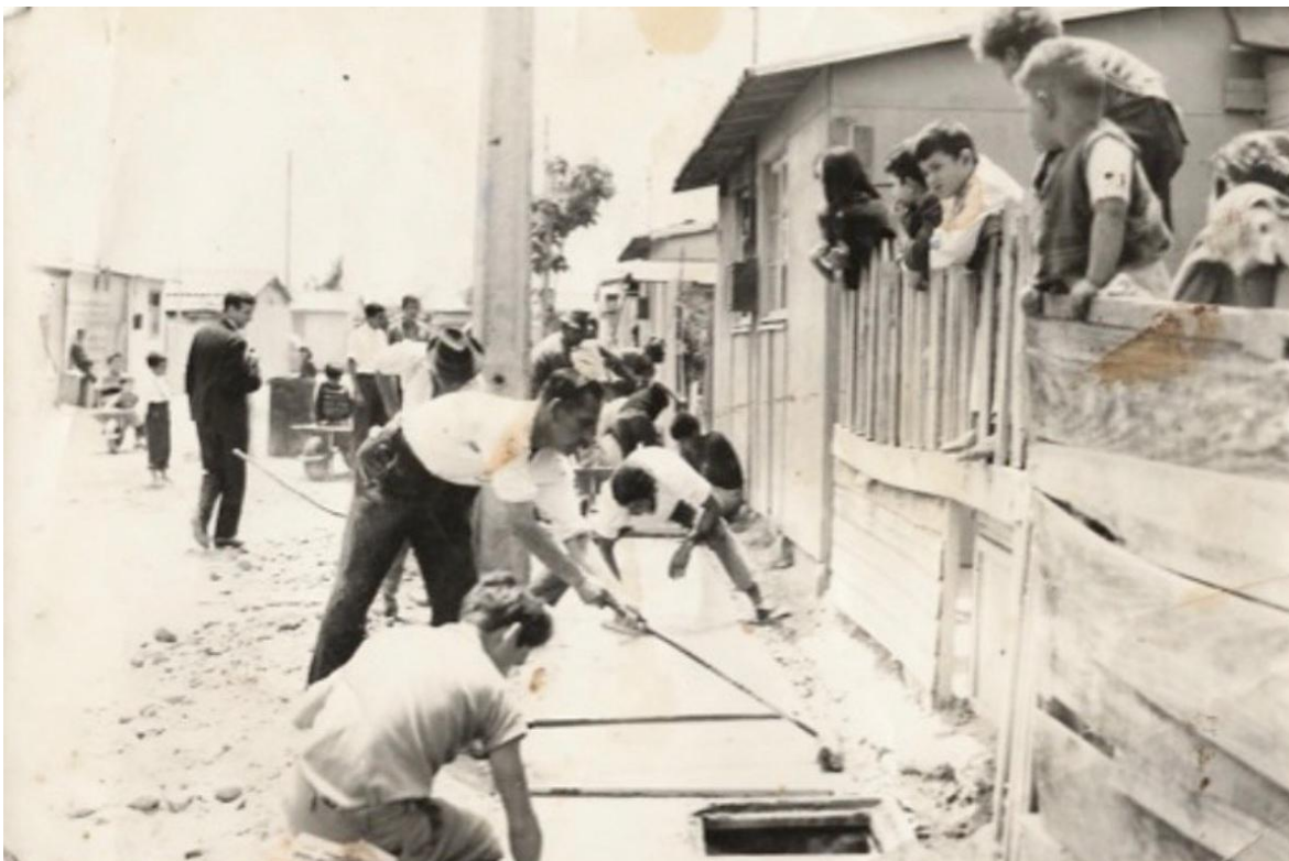
Autoconstrucción de veredas en la población José María Caro. Año: 1968. Archivo fotográfico: Orlando Gálvez. Fuente: La Caro: Un relato desde la solidaridad, la organización y la esperanza , Orlando Gálvez (2014). Capítulo 4: Entre todos construyendo La Caro . Pág. 119.
