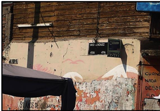
Imagen 91. Sin autor ni año de realización. Ubicación: Calle Galo González con 30 de octubre. Fuente: terreno realizado sábado 4 septiembre del 2010.
