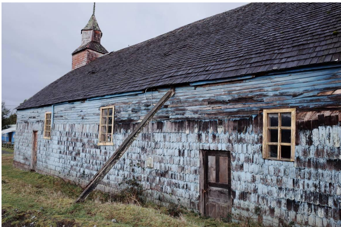
Fotografía n°13: Iglesia católica local: pilar que sostiene mura lateral de la estructura. Se planea a futuro instalar más pilares para reforzar la estructura.
