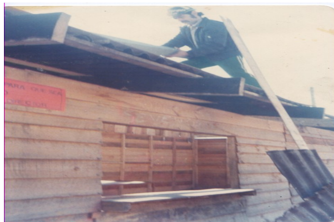
Foto 9: Apoyo en armado de viviendas por miembros de la Brigada de Emergencia (1985)
