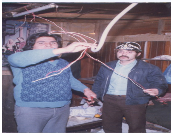
Foto 23: Reparación del sistema eléctrico en vivienda por voluntarios Brigada (1986)
