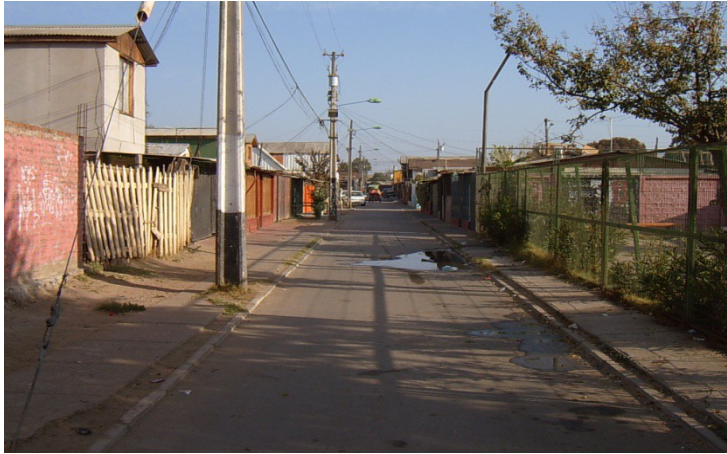
Foto 40: Pasaje Isla de Pascua esquina San Ambrosio A un costado la plaza y la sede social (2009)
