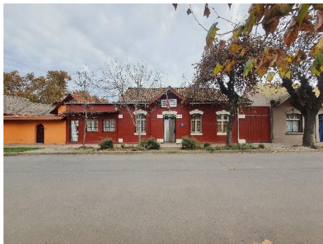
Edificación de un hastial. Fuente: elaboración propia (Imagen 005)
