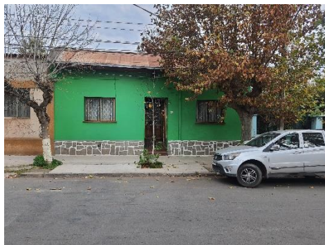
Edificación de 2 sin hastiales. Fuente: elaboración propia (Imagen 007)
