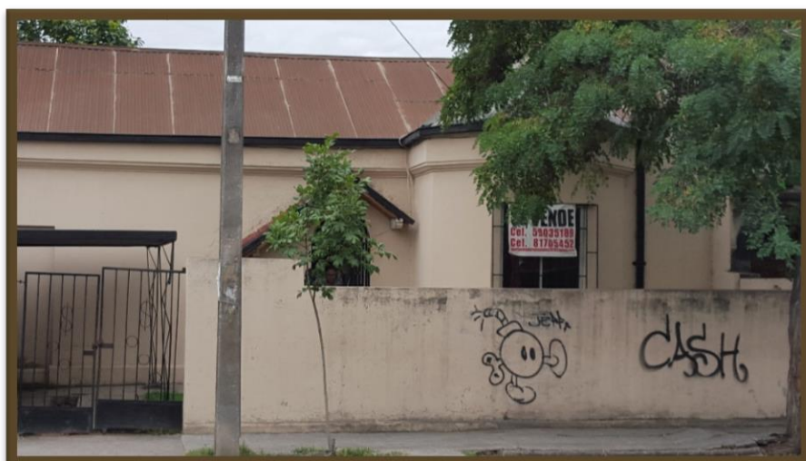
Av. Francia – Casa a la Venta con deterioro en la infraestructura Fotografía: Isabel González
