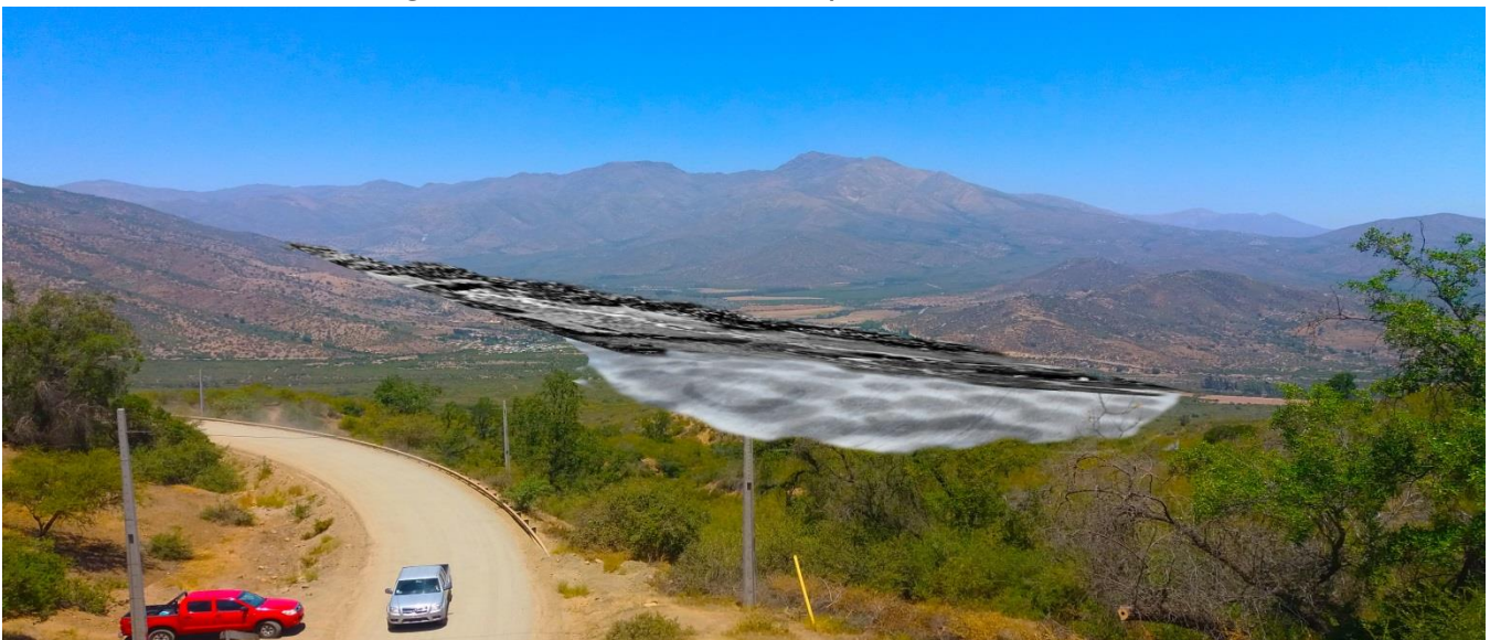
Imagen N°60: Intervención en punto túnel El Recto
