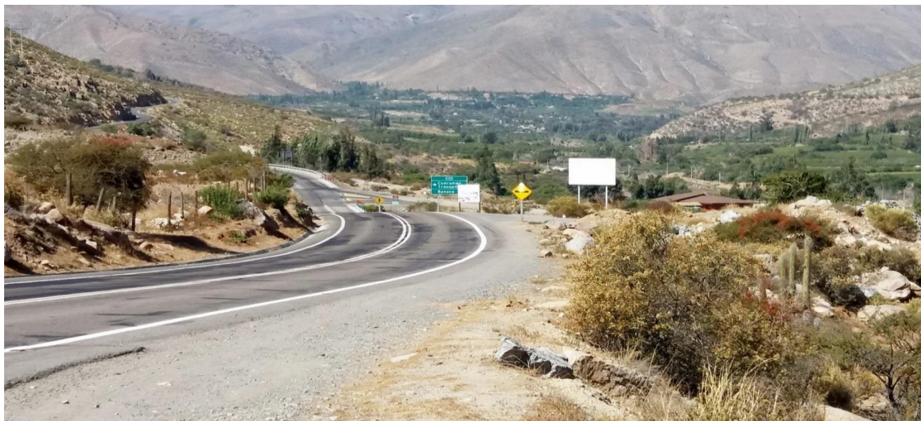
Foto N°14: Cruce Cuncumén y batuco.
