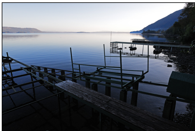
Foto N° 3: Muelles privados, construcciones que se encuentra cerrado.
