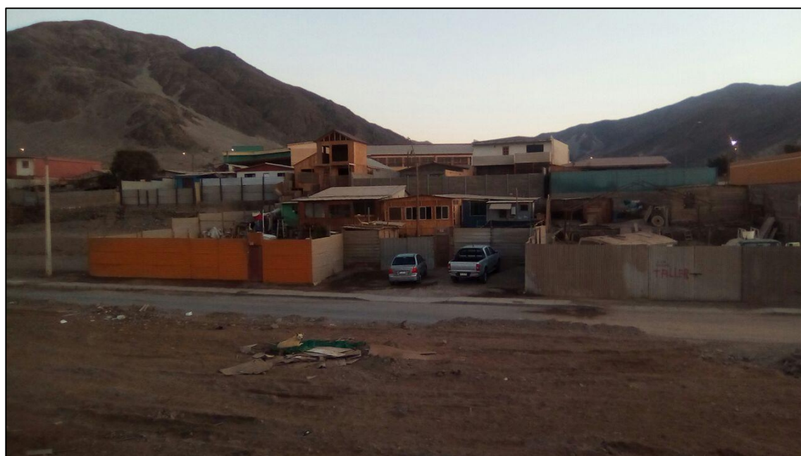
Fotografía 21: Población el Salado, zona destruida por el derrame de lodo
