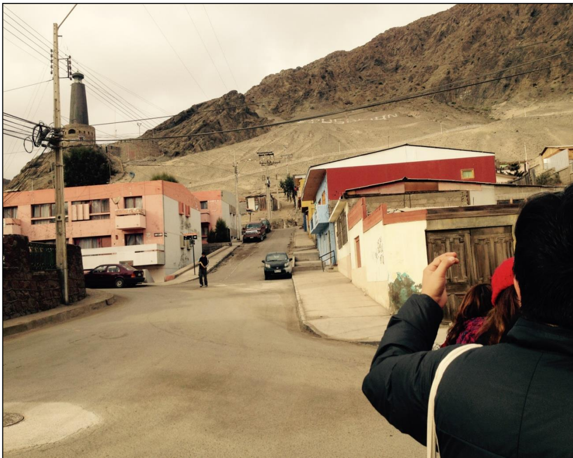
Fotografía 25: Pendiente y la ubicación de las edificación en el cono se derrubios.
