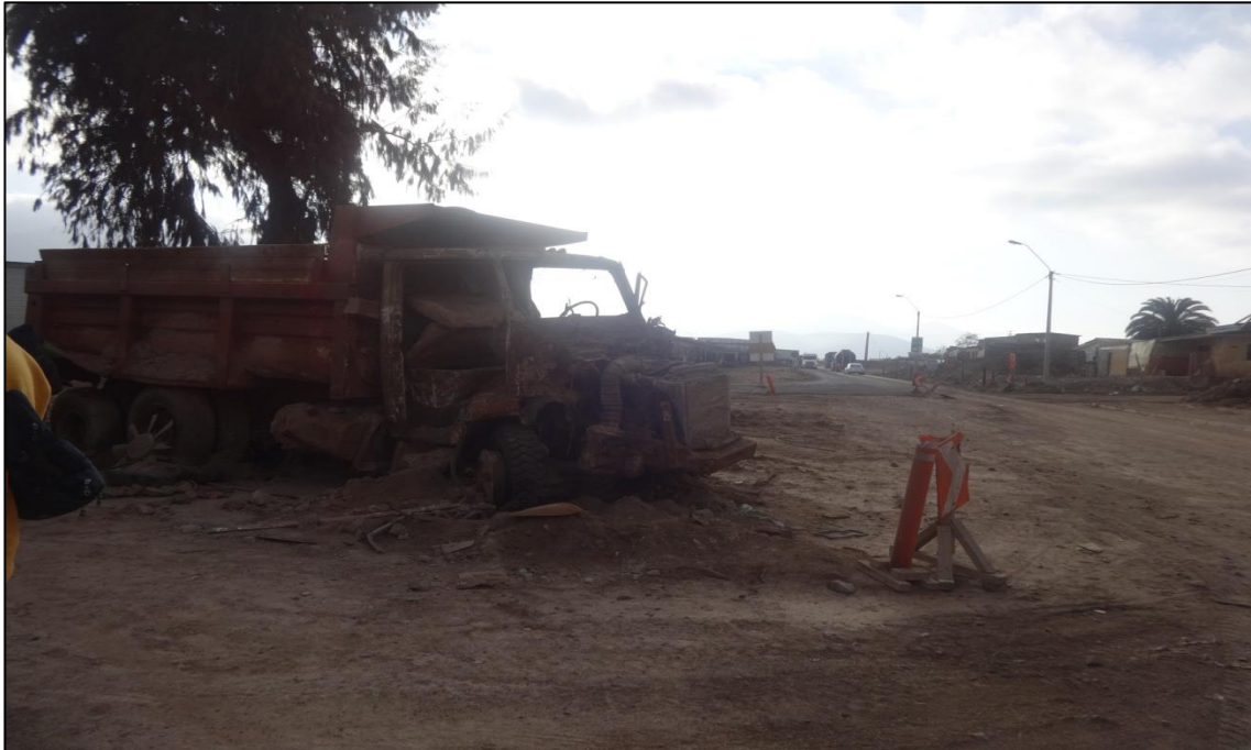
Fotografía X I: Costanera de la ciudad
