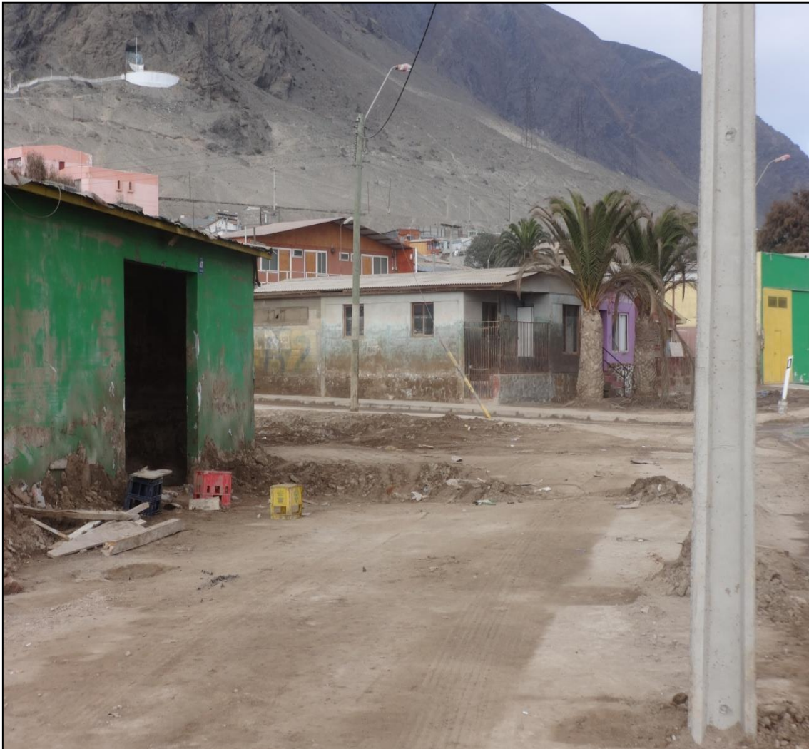
Fotografía 1: Calle sedimentada con lodo pos activación de quebradas
