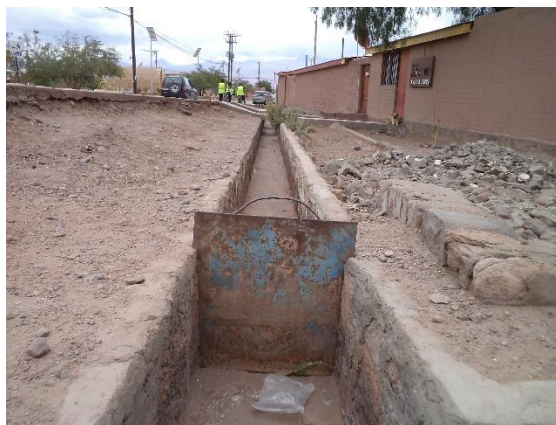
Ilustración 6 Canal de regadío de piedra con compuerta
