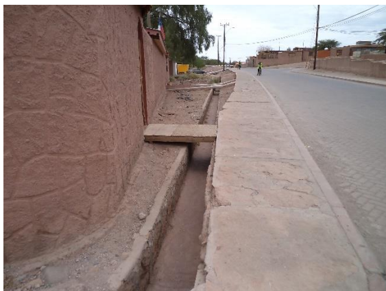
Ilustración 5 Canal de regadío de piedra con puente
