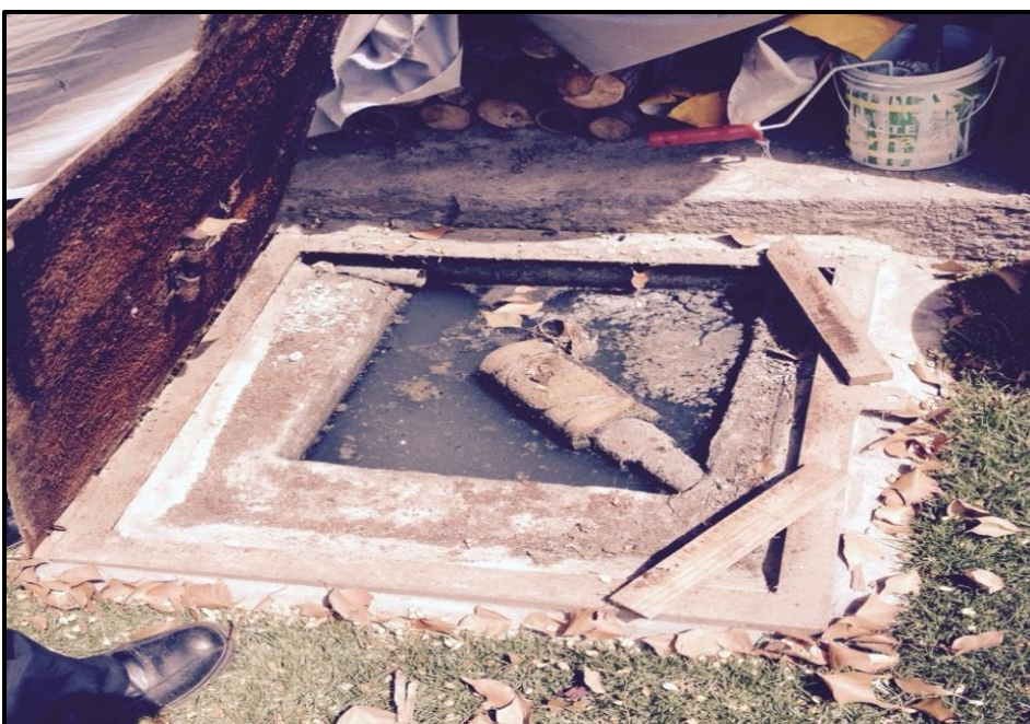
Figura 8: 1° etapa del reciclaje de aguas grises, recepción en el pozo. Fuente: archivo personal
