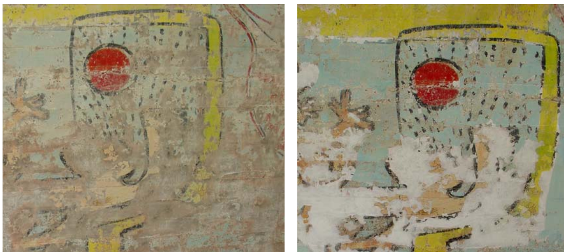
Izquierda, figura del arco en su real estado de conservación, luego del retiro de la capa de carbonato de calcio. Derecha, misma imagen, pero en un avanzado estado de reintegración de soporte.
