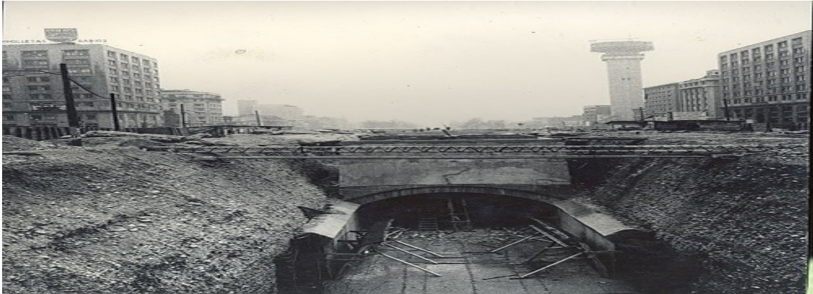
Construcción del metro tramo línea 1 en 1969, Fuente: www.metrosantiago.cl
