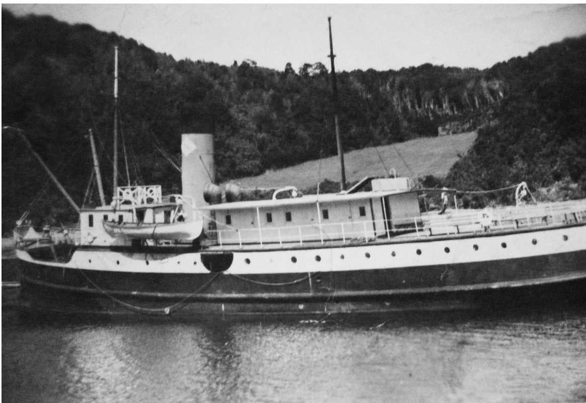
Figura 10: Fotografía del Remolcador Atlas, que perteneció a la firma Macaya desde el año 1936 hasta 1942. Fue construido en Holanda el año 1907, con casco de acero. Las medidas eran: Eslora; 34,86 mts, manga; 7,10 mts, puntal; 3,73 mts, Calado; 4,20 mts. Su peso era de aproximadamente 264,16 toneladas. (Colección privada de Juan Hernández).
