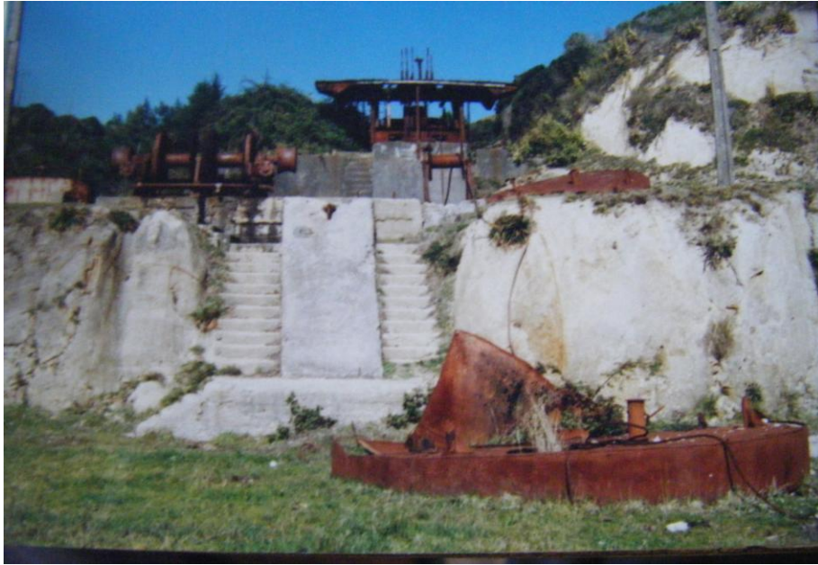
Figura 15: Fotografía que muestra como se organizaban los winches a lo largo de la planta, ya abandonados en el año 1996. (Colección privada de Carlos Macaya).
