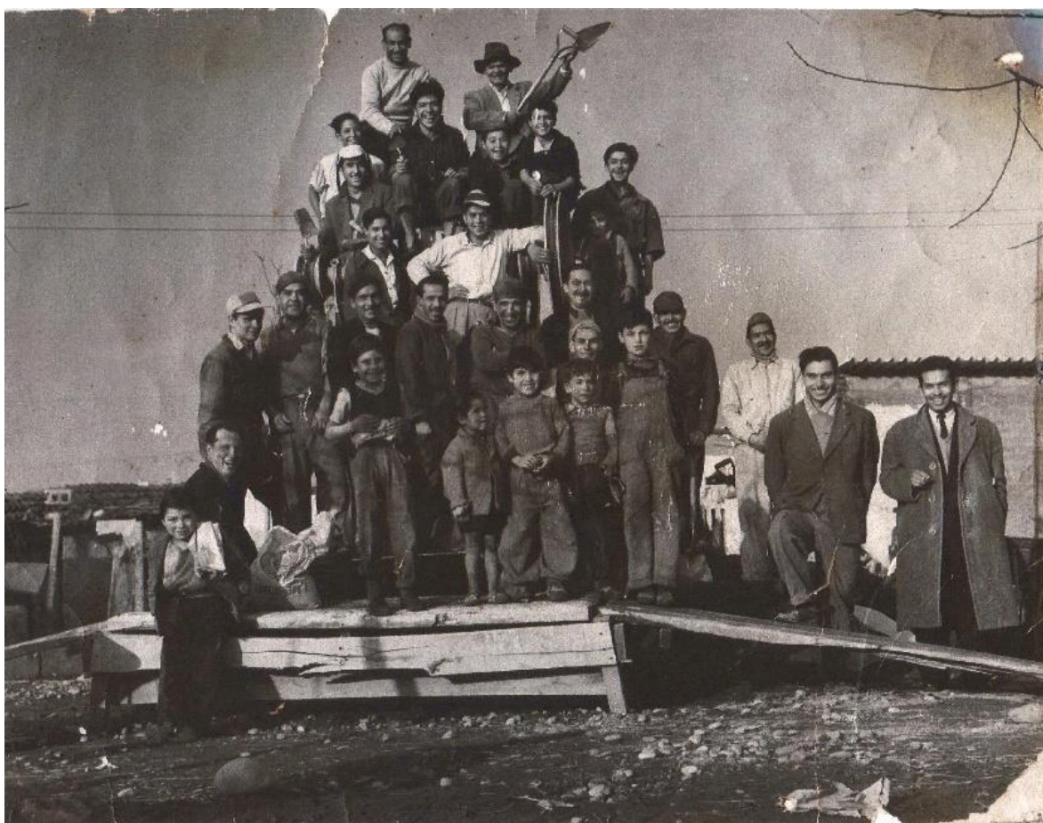
Figura 23: Cuadrilla de Construcción, Población Germán Riesco.
