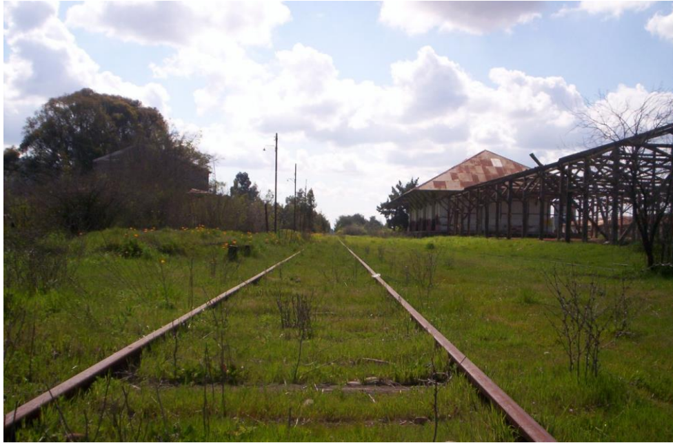
Durmientes Antigua Estación de Colchagua (2005)
