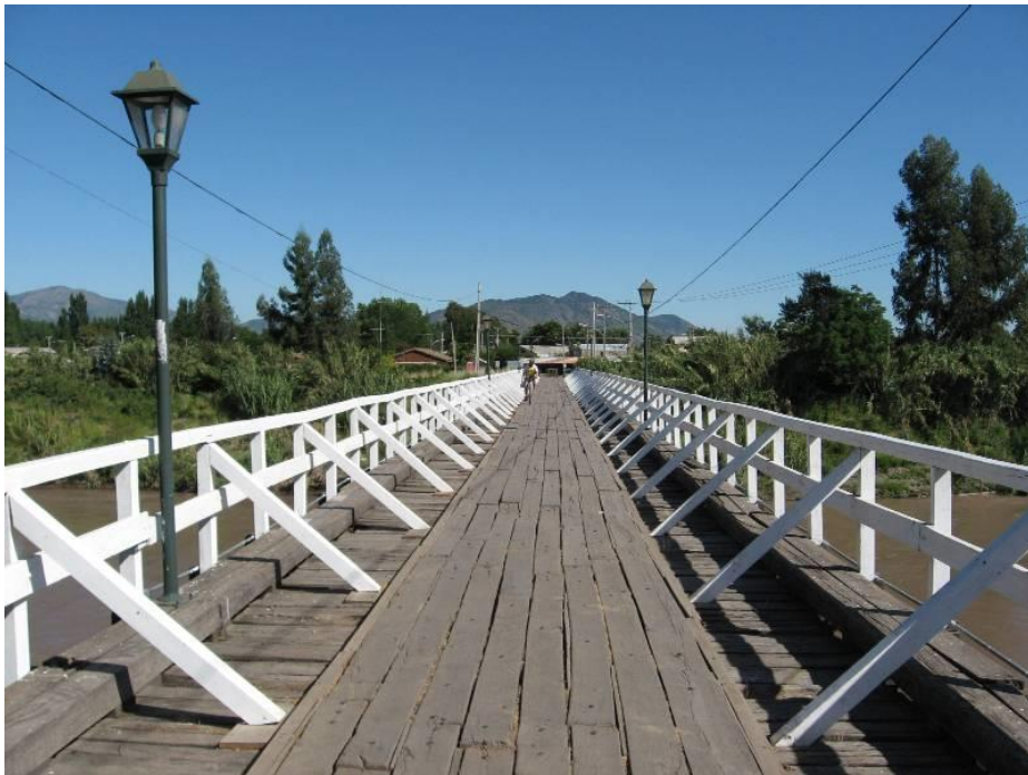
Antiguo Puente Tapado (2005)
