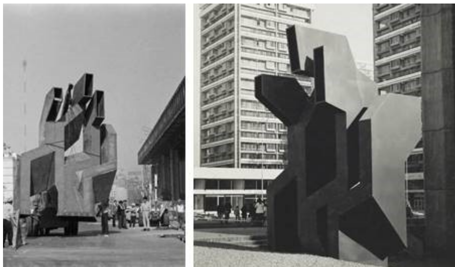
Imagen 13 Chimenea, 1971. Ensamblaje y colocación de la obra en el edificio UNCTAD III. Fotografía Fundación Félix Maruenda.
