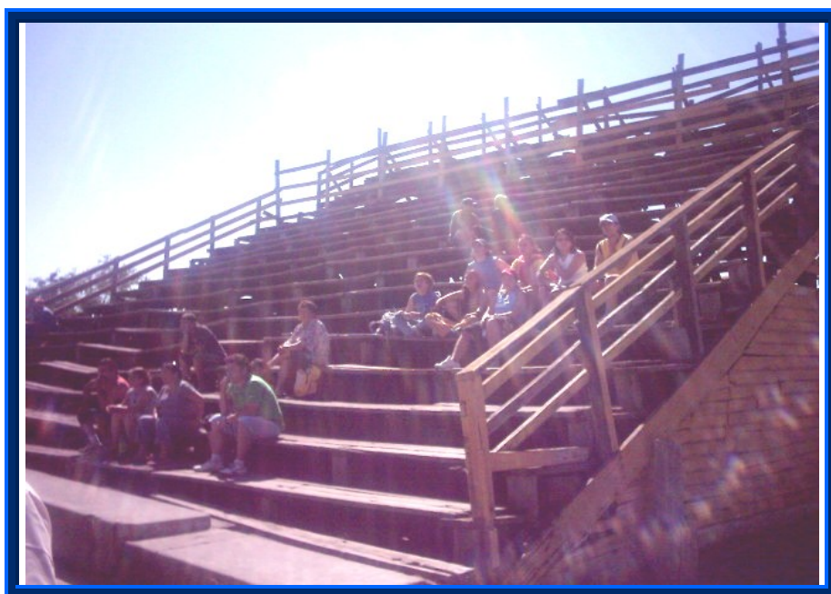
Fotografía N° 4: fuente directa Barra Ferroviarios.
