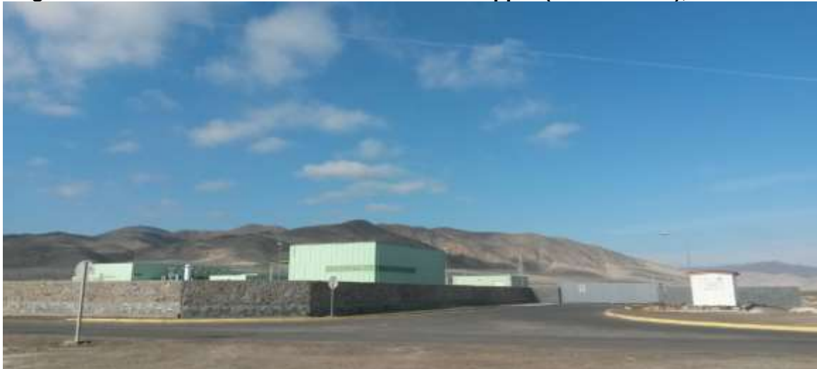
Imagen 4: Planta desaladora de la mina Mantos Copper (Manto Verde), en Flamenco.
