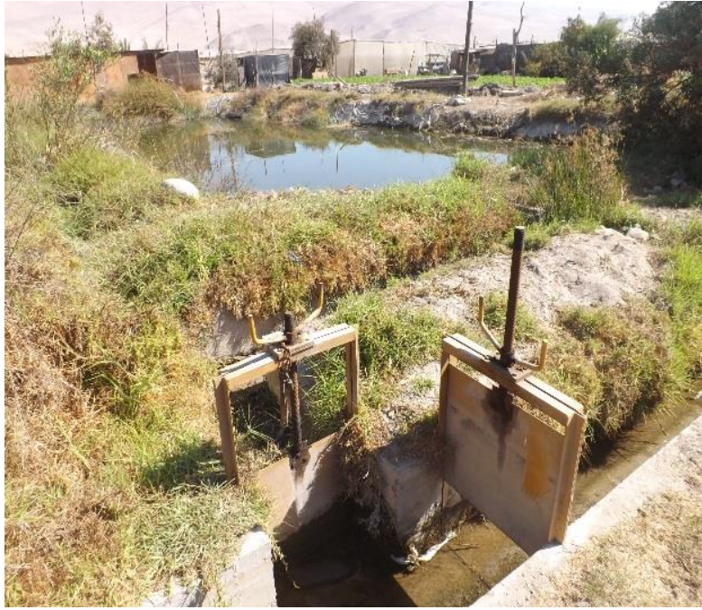
Estanque de acumulación junto al canal Lauca
