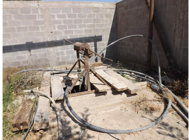
Sistema de recolección de aguas a través de pozo
