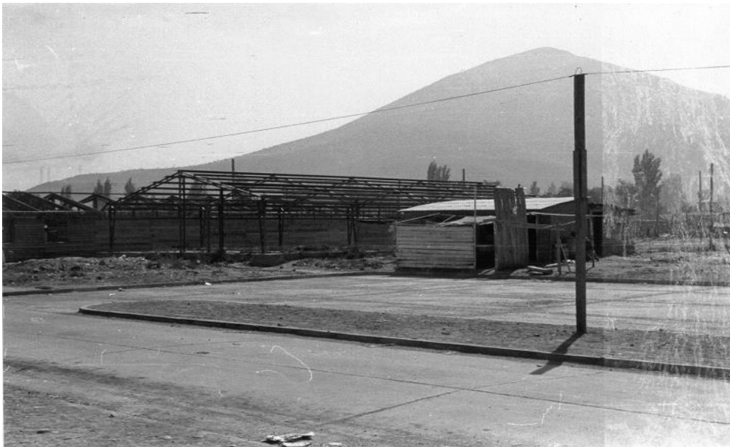
Imagen n° 12. Construcción del galpón y bodegas de materiales y herramientas. Donde posteriormente se levantará la sede de la Junta de Vecinos.
