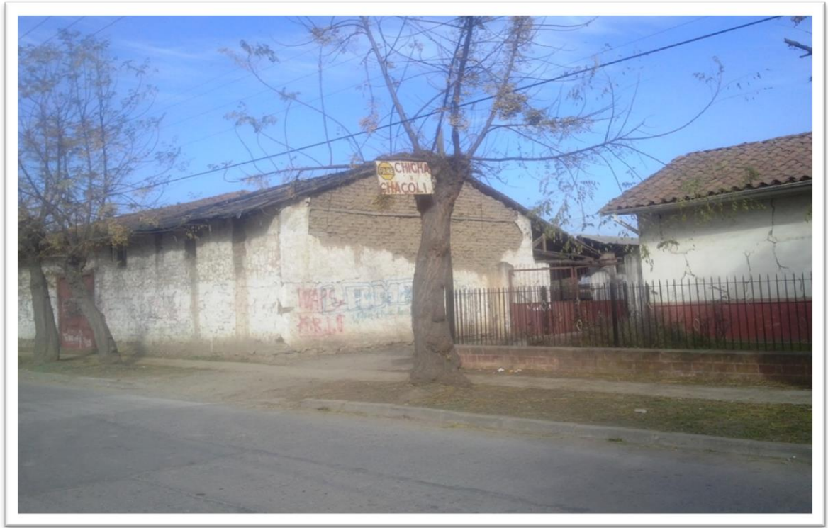
Figura 8. Al costado izquierdo se encuentra la bodega de producción y al costado derecho de la imagen la casa de su dueño y productor, don Carlos Carrasco. 12 de julio, Doñihue.
