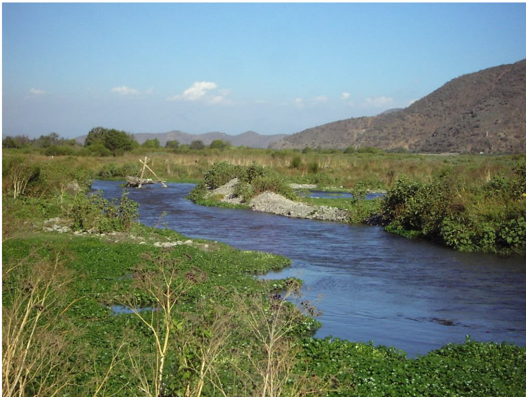
Unión de los ríos Mapocho y Maipo a la altura del callejón San Antonio: detalle de “Pata de Cabra” al fondo (estructura de madera triangular) para encausar las aguas.
