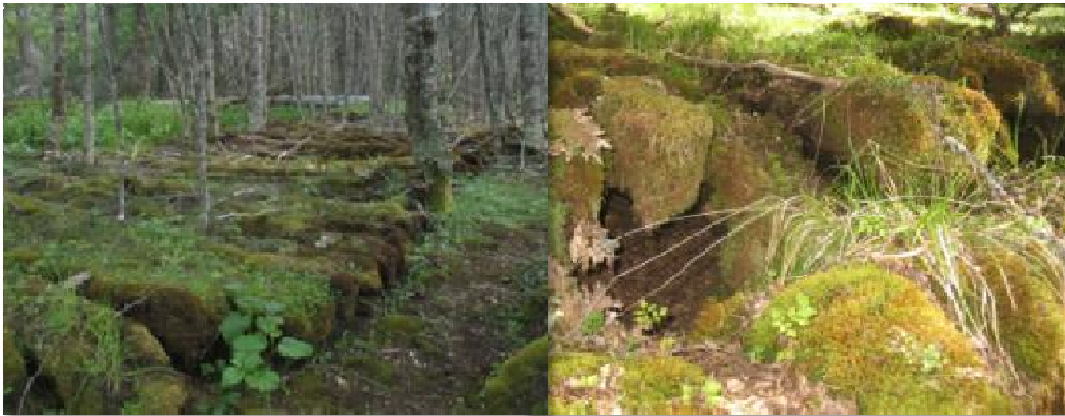
Fig. 31–32: Planchado de madera sobre el cual se adaptó y regeneró la vegetación del lugar. Construidos una viga al lado de la otra de manera horizontal sobre otras vigas que están puestas verticalmente en la superficie. En algunos casos se les hacía un corte para acomodarlas mejor.
