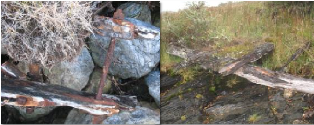
Fig. 12-13: Resto de pasarelas, muelle y, probablemente, vía férrea por donde acarreaman la madera.
