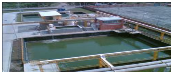
Figura 13: Piscinas de tratamiento de RILES. Fuente: MAC S.A., Infraestructura para el reciclaje de BAPU
