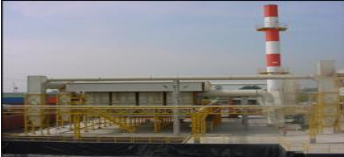
Figura 14: Fuente fija de una planta de fundición de plomo. Fuente: MAC S.A., Infraestructura para el reciclaje de BAPU .
