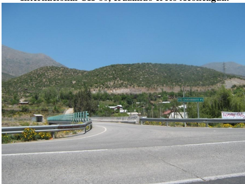
Fotografía N° 15: Puente de conexión Villa Aconcagua y Los Peumos con la carretera Internacional CH-60, cruzando el río Aconcagua.
