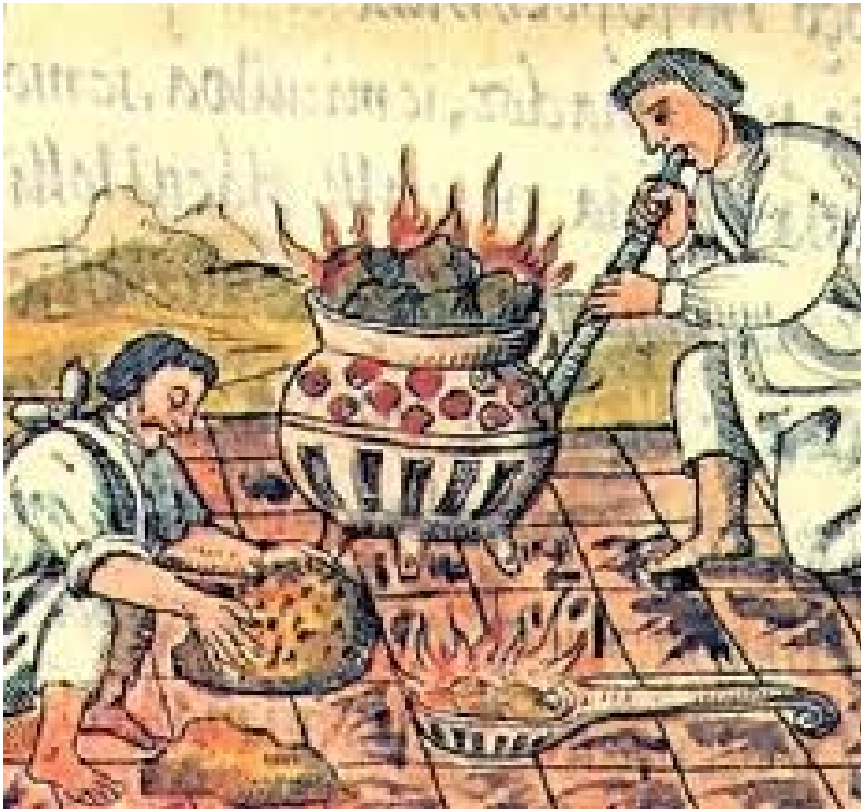
Ilustración 1: Imagen del Códice Florentino, donde uno de los orfebres sopla el fuego del horno con un cañuto y el otro prepara la cera para vaciar el metal que se encuentra en el crisol, esta se asemeja una a cuchara grande.
