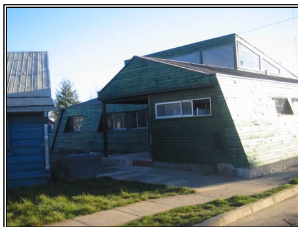
Imagen N°12.- Fotografía Fachada Posterior Edificio Municipal 215
