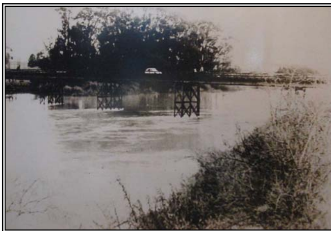
Imagen N°5.- Fotografía Puente Chol Chol Sobre Río Chol Chol Con Sus Pilares Cubiertos De Agua 318
