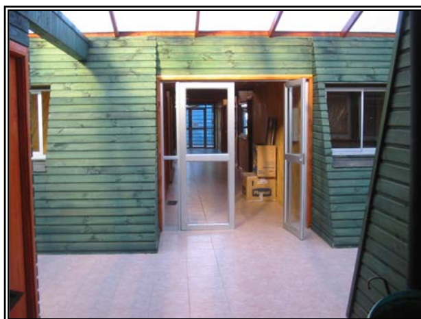
Imagen N°11- Fotografía Vista Interna Edificio Municipal 214
