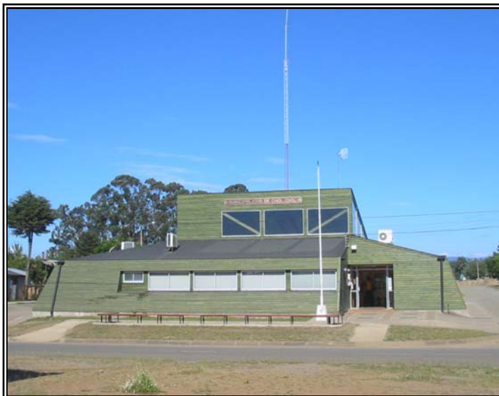
Imagen N°10.- Fotografía Fachada Edificio Municipalidad de Chol Chol 213
