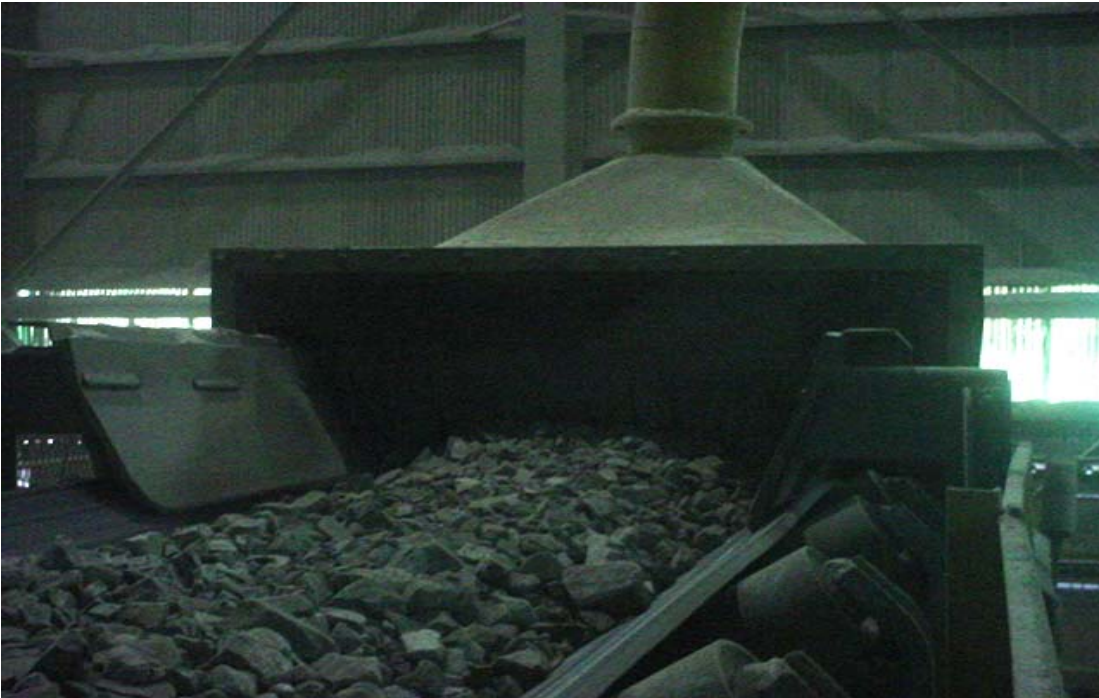
Fig. 53: Cola de chute de correa 102.
