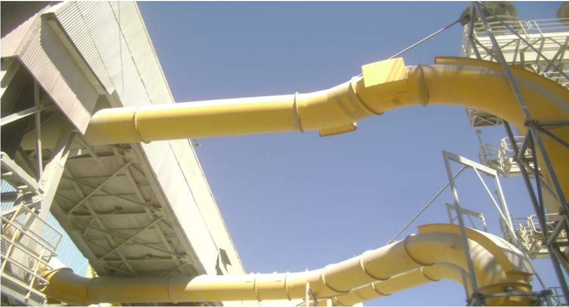
Fig. 29: Sistema de Ductería del Colector 10 y 11.
