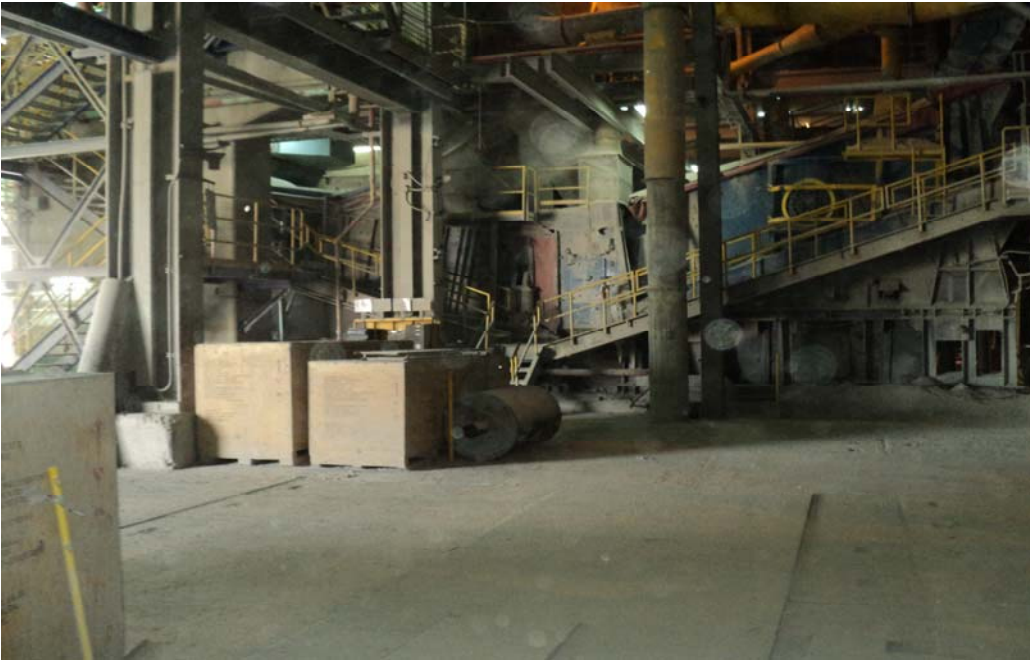
Fig. 14: Área piso principal.
