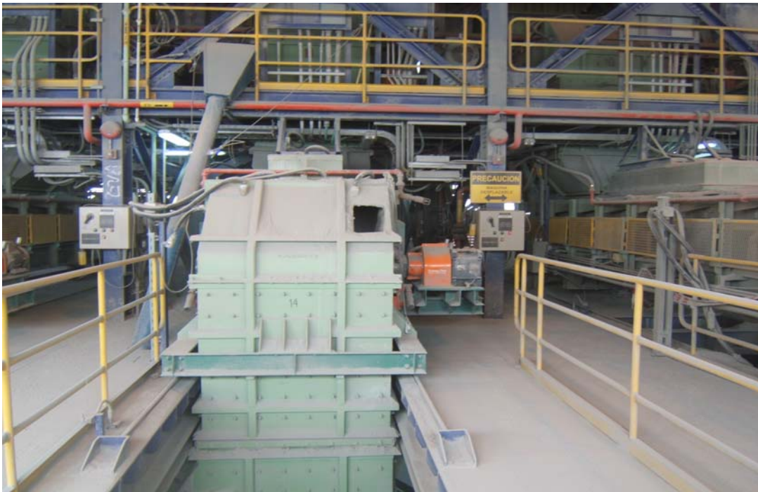
Fig. 50: Vista Frontal Chute de Traspaso Correa 103.
